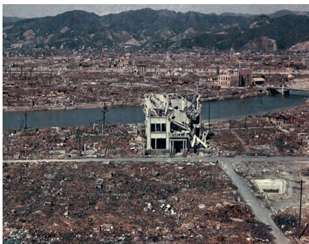
Рисунок 13 – Разрушенное нисходящим давлением бетонное здание в Хиросиме. Источник фотографии: https://bigpicture.ru/jarche-tysjachi-solnc-20-strashnyh-kadrov-v-pamjat-o-jadernom-vzryve-v-hirosime/ (дата обращения: 14.08.2023)
