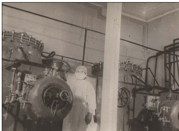
Рисунок 7 – Аппараты-культиваторы системы НИИЭГ (часть аппаратного зала). Киров, 1945 г. (фотография филиала ФГБУ «48 ЦНИИ» Минобороны России)
