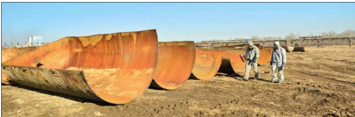
Рисунок 7 – Фрагментированные железнодорожные емкости, расположенные на специально подготовленной площадке (октябрь 2020 г., фотографии авторов)
