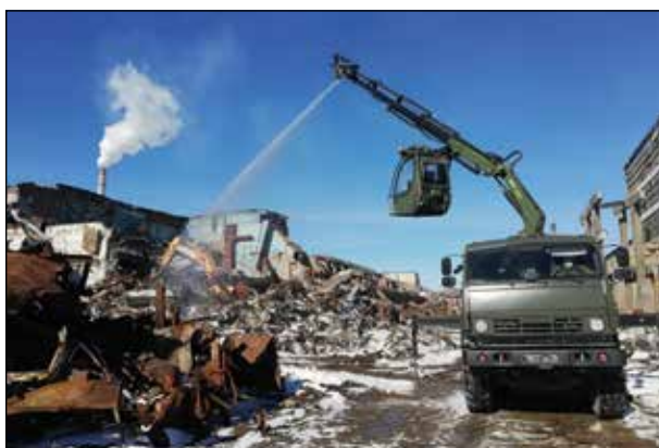
Рисунок 14 – Пылеподавление с использованием УТМ-80М при демонтаже надземной части цеха ртутного электролиза (октябрь 2020 г., фотография авторов)
