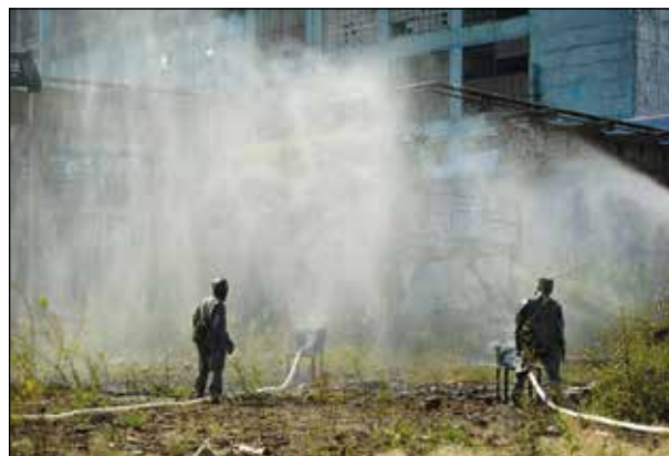
Рисунок 10 – Вспомогательный стол и выставляемая с его помощью щелочная завеса (октябрь 2020 г., фотографии авторов)
