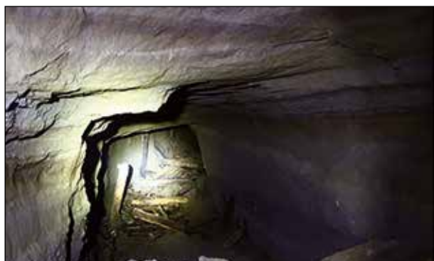
Рисунок 10 — Потерна между оборонительными сооружениями
